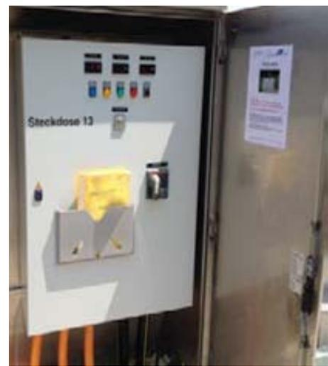
Powerlockstationen mit 400 A, wie die hier dargestellte, sind aktueller Standard für die Landstromversorgung von Flusskreuzfahrtschiffen.
